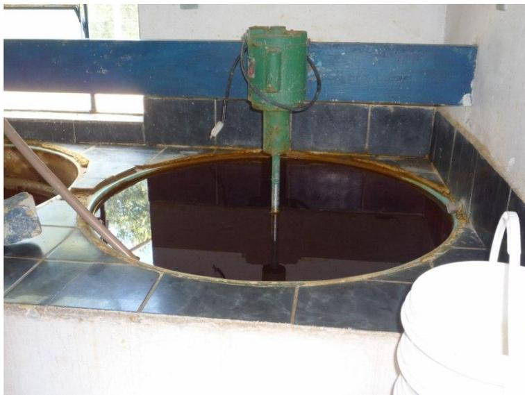
**Foto 12 – Reservatório de Sulfato de Alumínio**
