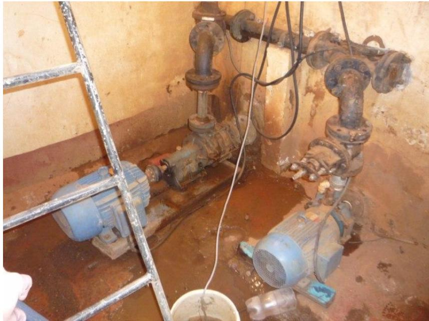
Foto 7 – Conjunto moto-bomba para recalque da água bruta
