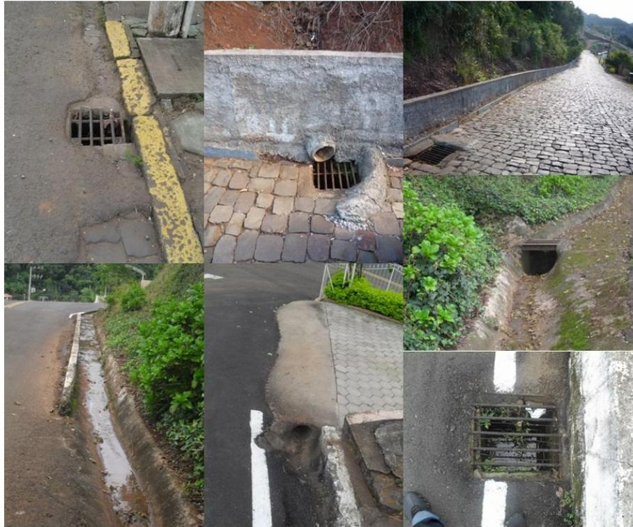
**Foto 48 – Coletores de águas pluviais**
