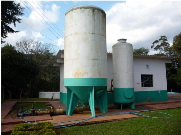
**Foto 11 – ETA Compacta Metálica Fechada com: Turbo Reator, Floculador-decantador e Filtro de Areia**
