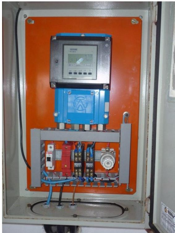
Foto 16 – Macromedidor eletromagnético de água tratada
