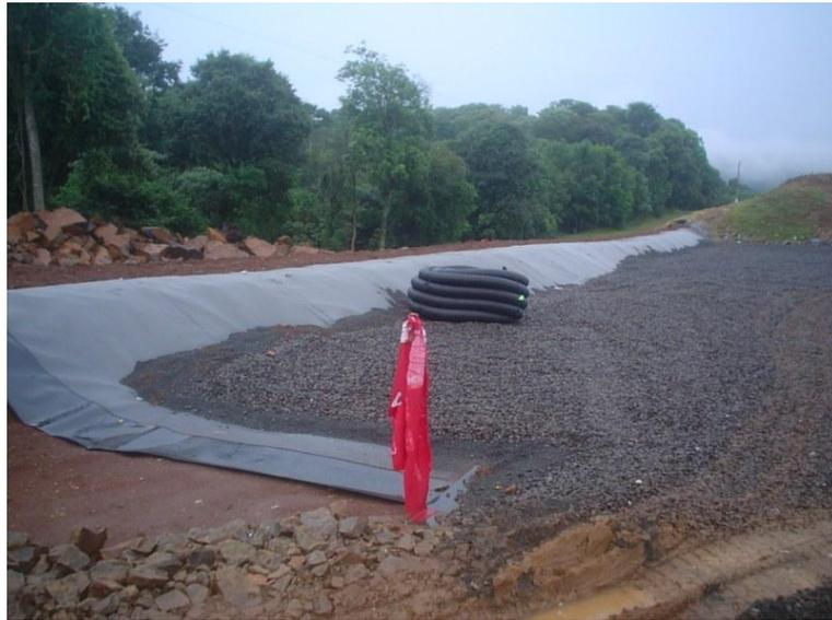
Foto 40 – Sistema de isolamento da célula de disposição final
