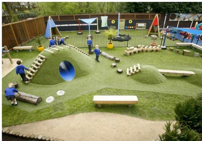
As montanhas serão executadas com preenchimento em pó de pedra e camada de concreto. Terão acesso ao topo por escadas de madeira elaborada com toras de eucalipto tratado medindo 6 cm de diâmetro. Deverão ser revestidas com grama sintética fibrilada.
