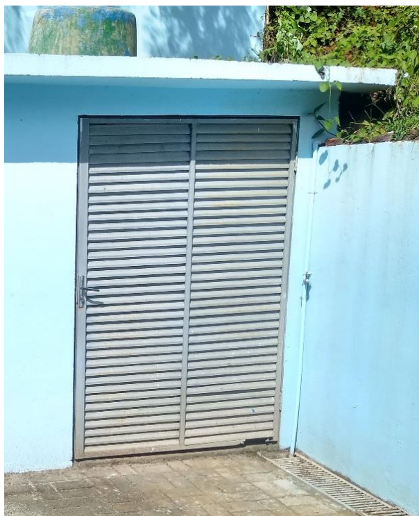
Figura 25 - Área de armazenamento de resíduos na UBS de Ibicaré. Fonte: Aquabona, 2021.
