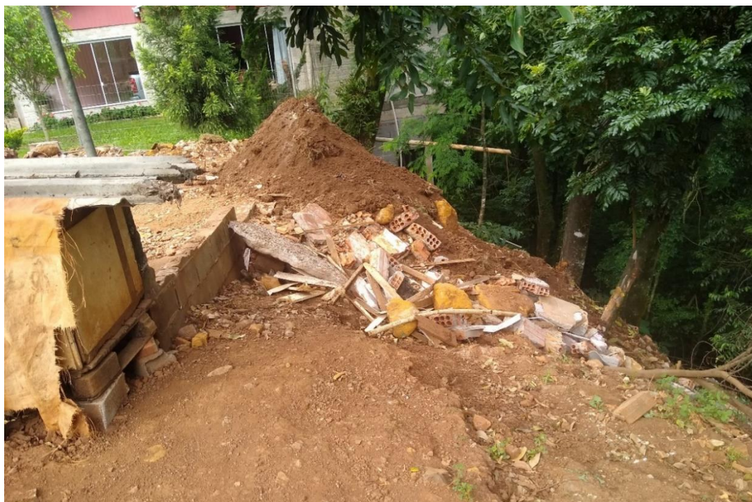
Figura 27 - Área de disposição de RCC para aterramento, Ibicaré, SC. Fonte: Aquabona, 2021.
