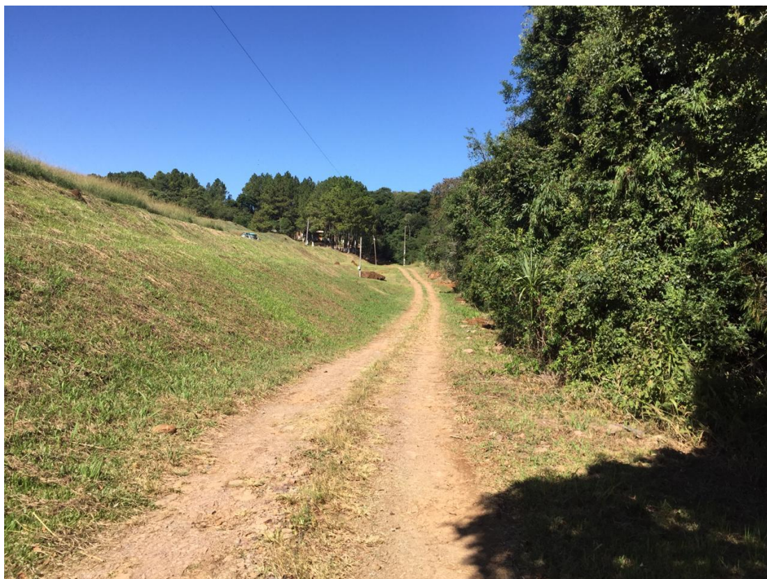
Figura 15 - Acesso do aterro sanitário em Erval Velho. Fonte: T.O.S., 2021.
