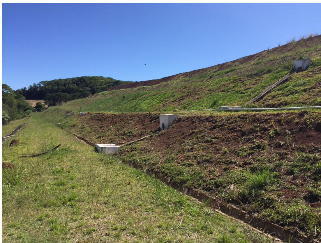
Figura 18 – Aterro sanitário em Erval Velho. Fonte: T.O.S., 2021.
