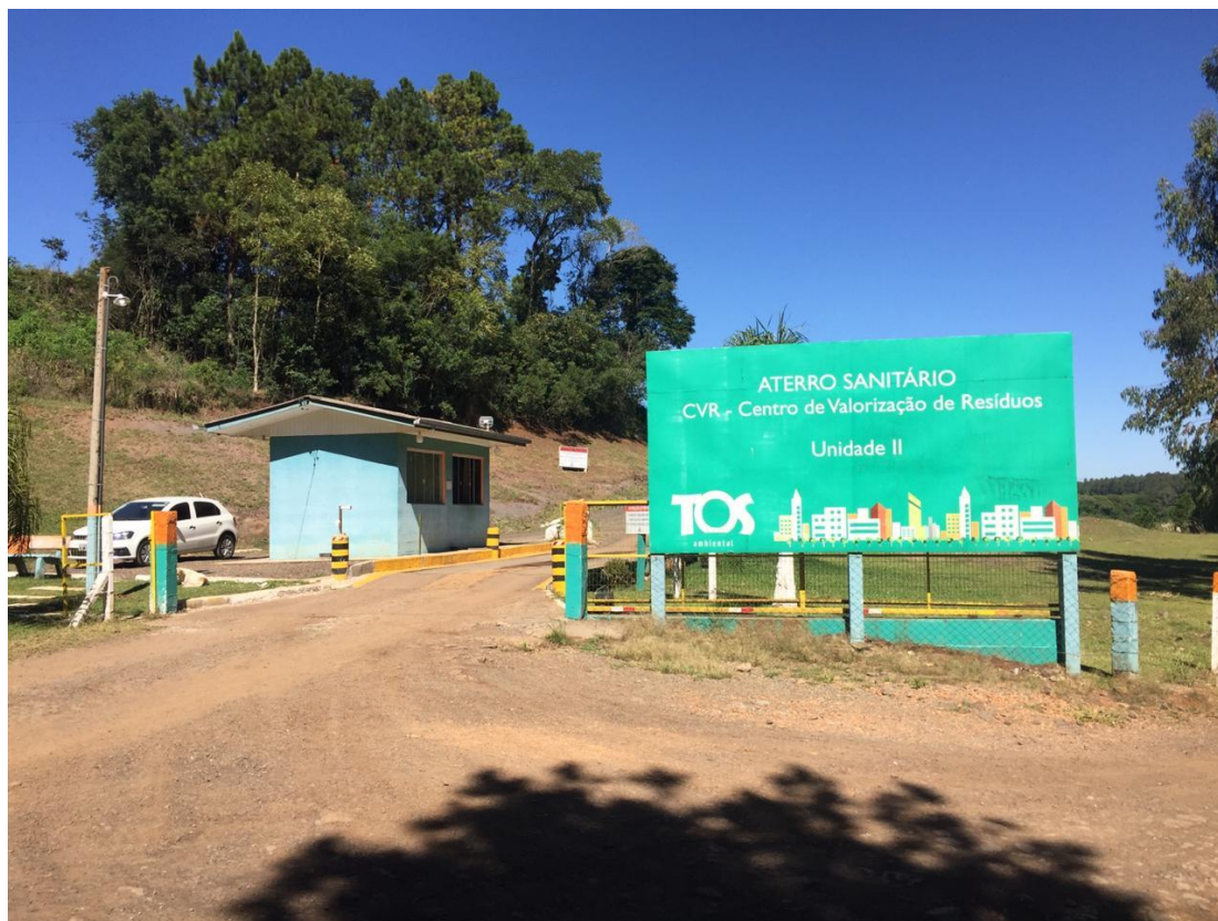
Figura 14 - Entrada do aterro sanitário em Erval Velho. Fonte: T.O.S., 2021.
