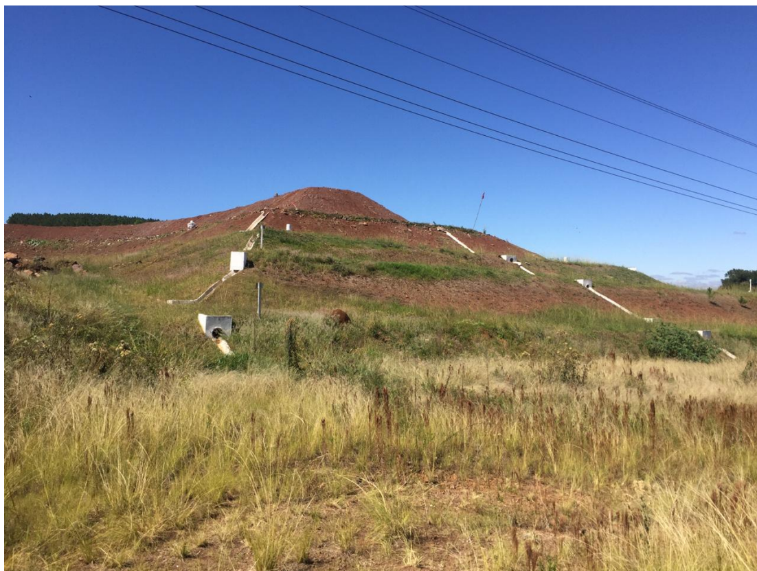
Figura 17 – Aterro sanitário em Erval Velho. Fonte: T.O.S., 2021.
