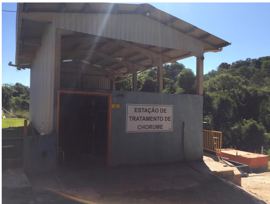
Figura 19 – Estação de tratamento de chorume do aterro sanitário em Erval Velho. Fonte: T.O.S., 2021.
