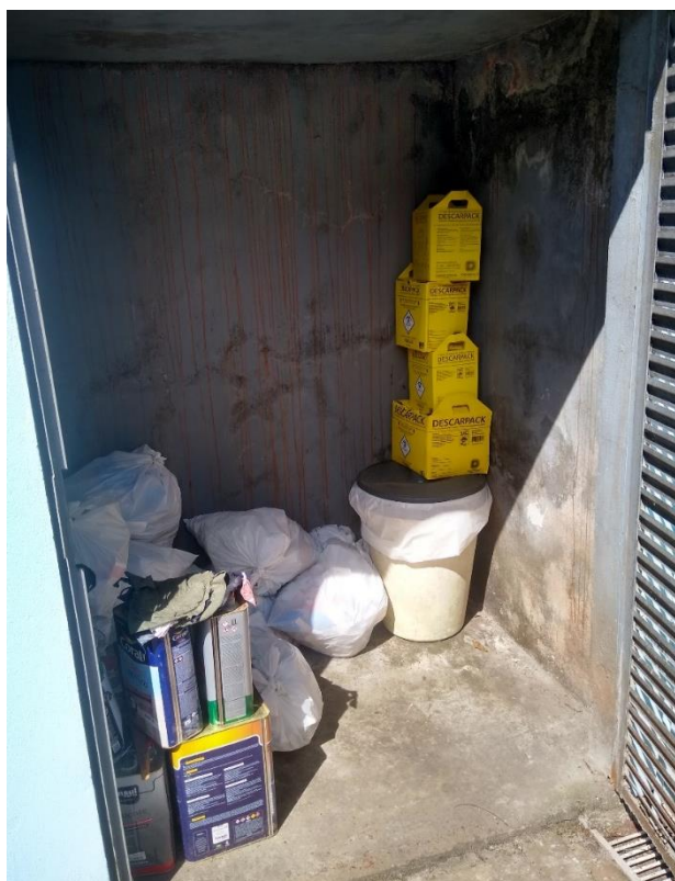
Figura 26 - Área de armazenamento de resíduos na UBS de Ibicaré. Fonte: Aquabona, 2021.
