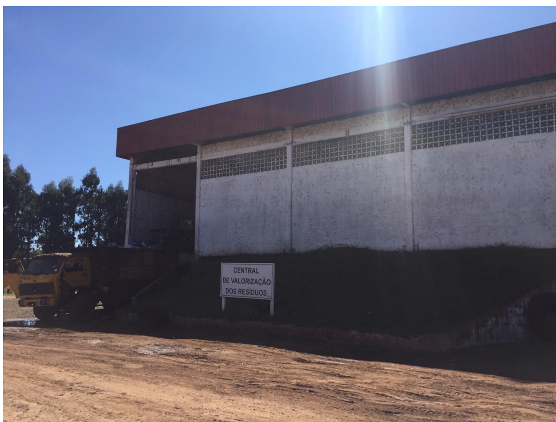
Figura 16 – Central de valorização de resíduos do aterro sanitário em Erval Velho. Fonte: T.O.S., 2021.
